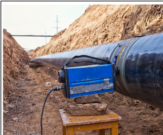
Inspección con rayos X de las uniones soldadas de una tubería.
