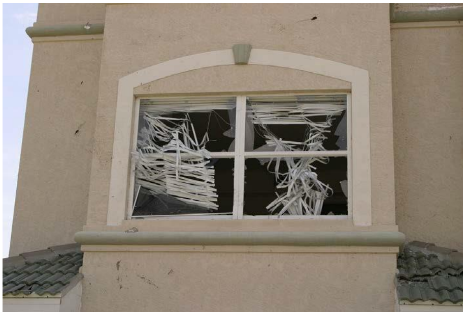
Vidrios de ventanas quebrados a causa de escombros impulsados por el fuerte viento
