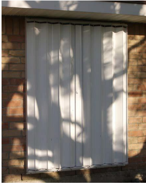
Sistema de contraventana resistente instalado sobre una ventana
