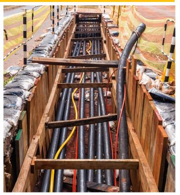
**Sobrecargas de peso** – Estas son cargas que son generadas por el peso de cualquier cosa que esté cerca de la excavación que pueda provocar un derrumbe (cualquier cosa en la parte superior que ponga presión). Algunas sobrecargas de peso comunes son causadas por el peso de:
