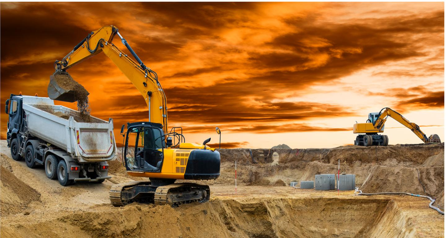
Nunca permita que los empleados trabajen en los lados de la inclinación o en una excavación escalonada por encima de otros trabajadores a menos que los trabajadores en la parte de abajo estén protegidos contra la caída de materiales. De ser posible, incline el declive en dirección contraria a la excavación. Esto tiene el doble propósito de evitar que el equipo y los vehículos se deslicen accidentalmente en la excavación y para evitar que el agua de lluvia se acumule en la excavación.
