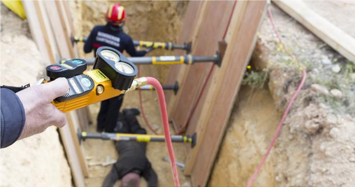
que se proporcione un sistema de apoyo u otro método de protección para proteger a los empleados de posibles derrumbes estructurales.
