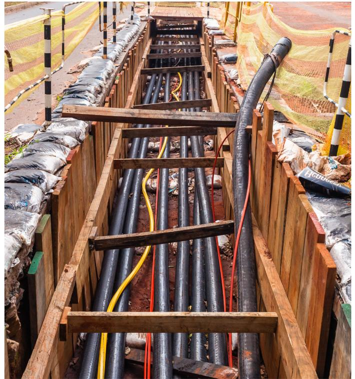
**Sobrecargas de peso** – Estas son cargas que son generadas por el peso de cualquier cosa que esté cerca de la excavación que pueda provocar un derrumbe (cualquier cosa en la parte superior que ponga presión). Algunas sobrecargas de peso comunes son causadas por el peso de:
